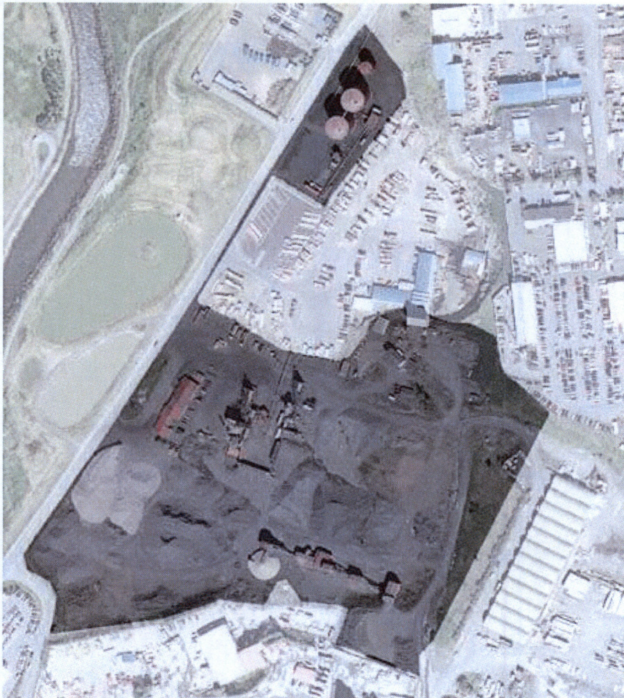
Yfirlitsmynd af athafnasvæði fyrirtækisins við Sævarhöfða 6-10.
